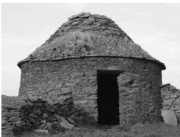
Siendo dos los principales rasgos arquitectónicos a destacar en la construcción de los chozos de piedra: La técnica de “piedra seca” y el cerramiento por falsa cúpula.
